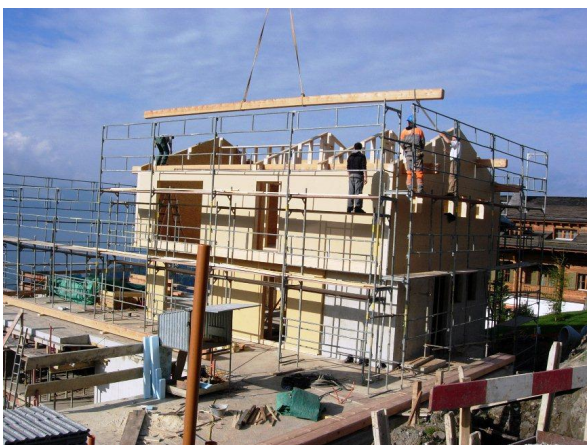
Montage de la charpente bois
