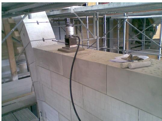
Mise en tension des tirants verticaux de renforcements dans les contreforts
