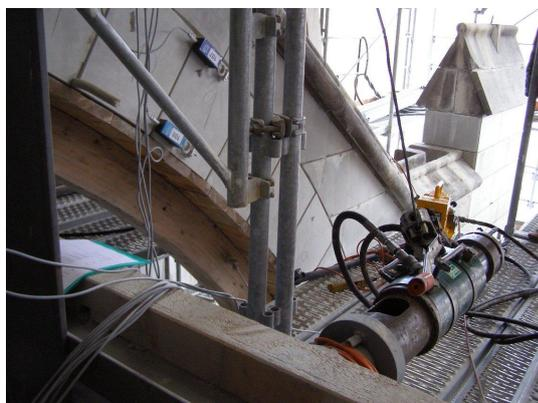
Monitoring des contraintes in situ lors de la mise en tension des tirants provisoires
