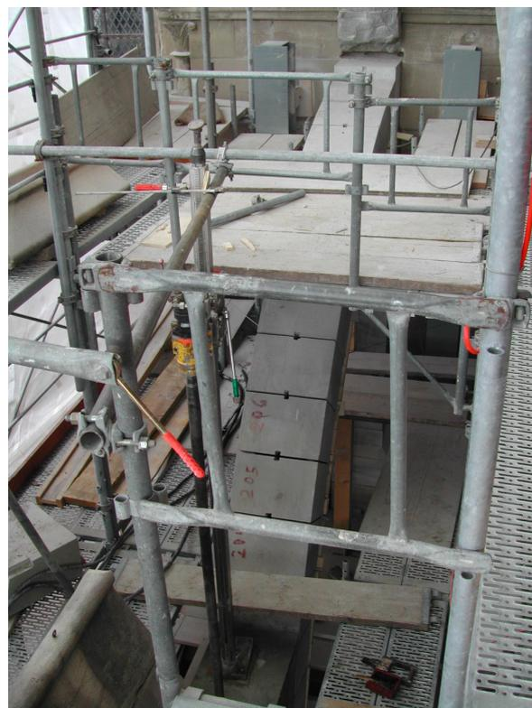
Remplacement des voussoirs des arcs-boutants et forages dans les contreforts pour mise en place des tirants verticaux de renforcement
