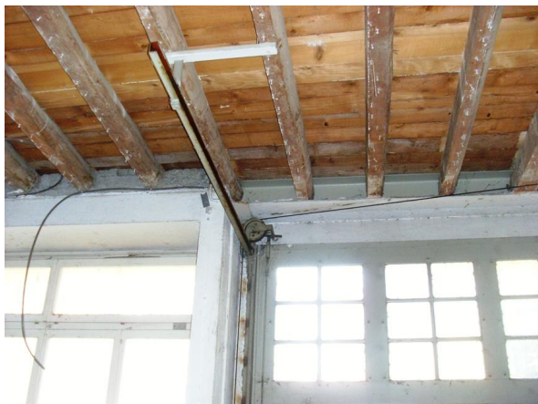
Plancher avant les renforcements
