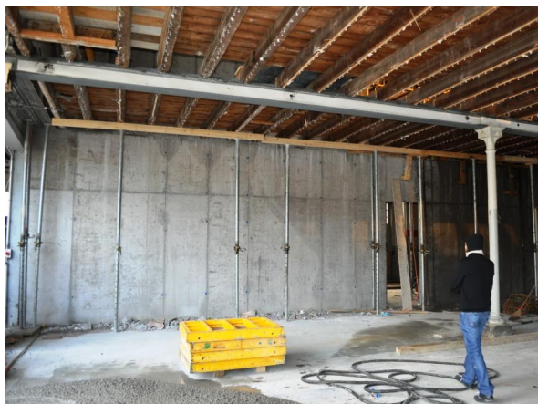
Plancher avec le nouveau renforcement métallique
