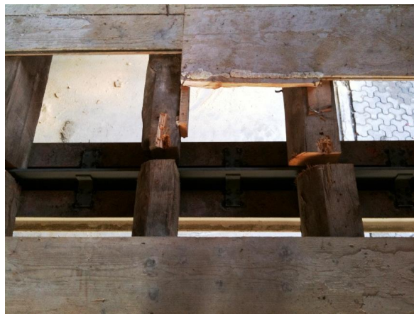
Plancher posé sur un profilé métallique
