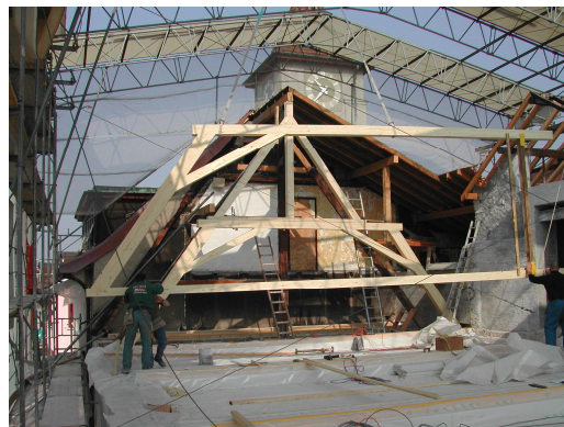
Remplacement de la charpente de la toiture et d'un beffroi pour les cloches.
