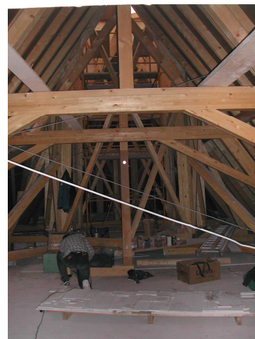
Création d'un nouveau plancher des combles (plafond de la nef), d'une charpente de toiture et d'un beffroi pour recevoir 2 cloches
