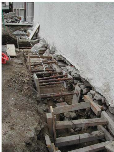
Confortement des fondations.
