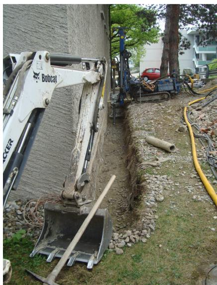
Terrassement préalable pour forage et mise en œuvre des micropieux
